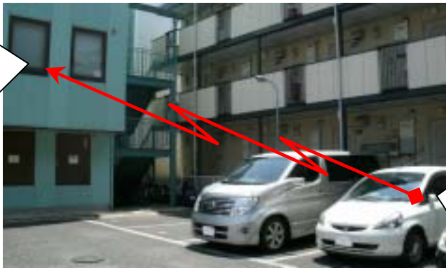
図2:設置環境外観
